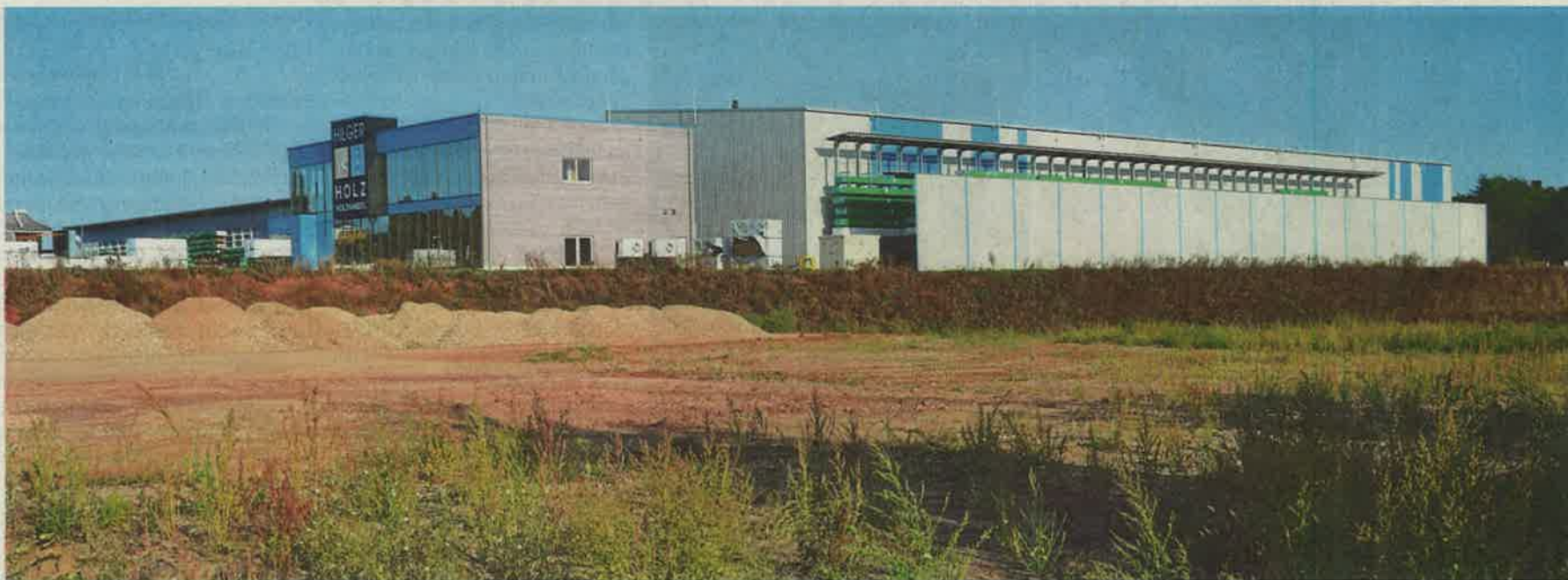
Auf der Fläche (im Vordergrund) neben dem neuen Unternehmenssitz soll der Erweiterungsbau von Hilger-Holz entstehen.
