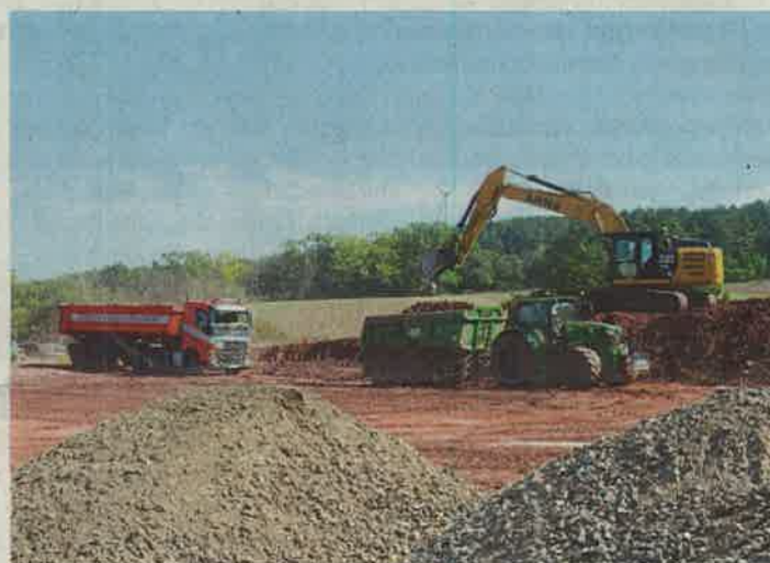
Das Grundstück für den Neubau von „X-Wood“ aus Büllingen im Gewerbegebiet III wird zurzeit baureif gemacht.
